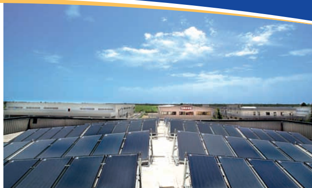
SOAVEGEL Fabbrica Surgelati - Francavilla Fontana (BN) 60 pannelli - 114 mq Acqua calda per le fasi di cottura e lavaggio dei macchinari
